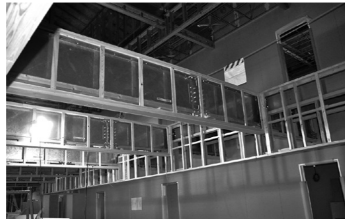
吹抜けのある中央ホール
