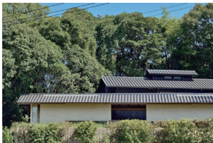
外観。2棟の屋根が折り重なる
