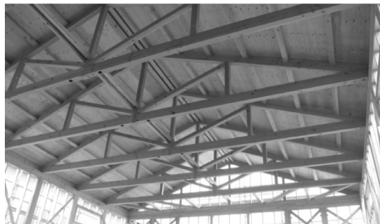
流通製材と住宅用プレカットによる12mパツ山形トラス
